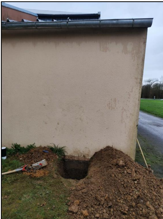
Figure 4 : Coupe de la reconnaissance de fondation RF1
