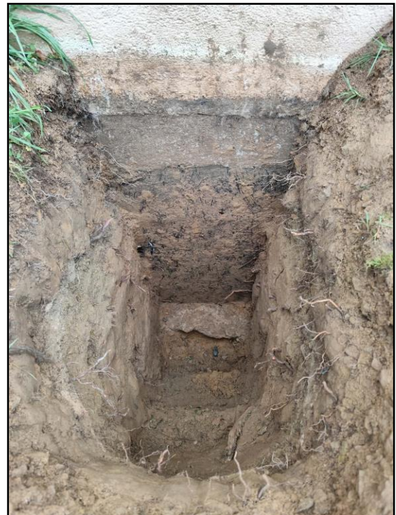
Figure 4 : Coupe de la reconnaissance de fondation RF1
