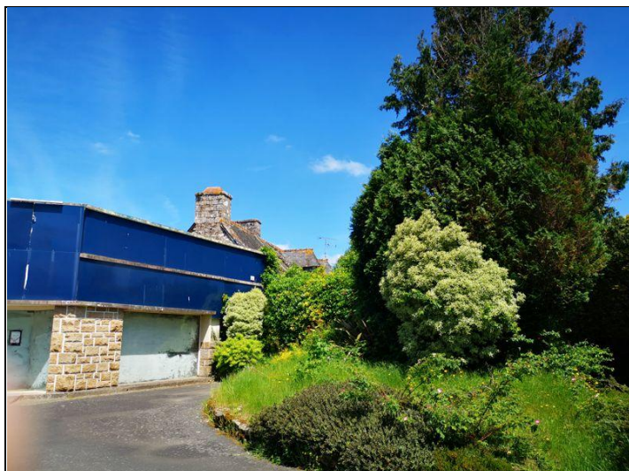
Photo 1 : Extrémité sud du site, ancien magasin (entrée de la rue Madeleine).
