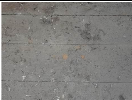
Photo n° PhTer002 Localisation : Combles - Grenier Ouvrage : Parquet Parasite : Anobium punctatum (Petites vrillettes), Xestobium rufovillosum (Grosses vrillettes) Indices : dégradation du bois, présence de trous de sortie, présence de vermoulure sur le sol
