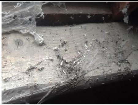
Photo n° PhTer001 Localisation : Combles - Grenier Ouvrage : Charpente Parasite : Anobium punctatum (Petites vrillettes) Indices : présence de trous de sortie, présence de vermoulure
