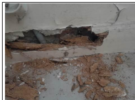
Photo n° PhTer006 Localisation : Rez de chaussée - Cagibi Ouvrage : Plinthes Parasite : Anobium punctatum (Petites vrillettes) Indices : dégradation du bois, présence de trous de sortie
