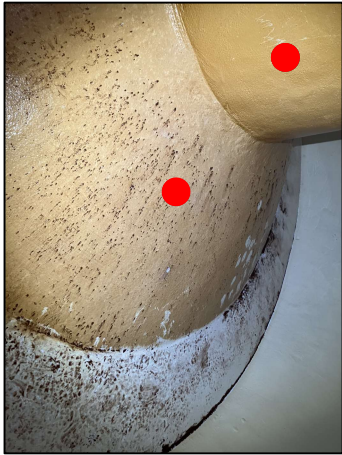
Ind0/P49 - Enduit avec revêtement d'imperméabilisation peinture contenant de l'amiante Chrysotile (sur le dôme au sol) / A
