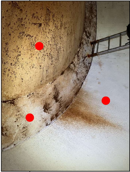
Ind0/P50 - Enduit avec revêtement d'imperméabilisation tissé contenant de l'amiante Chrysotile (chêneau, au sol) / A
