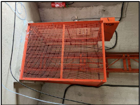
Peinture sur tous les éléments métalliques associés à l'ascenseur (cabine, cage de protection, porte palier, mécanisme, guides, ... // valeur comprise entre 9,48 (v=1,76) et 12,11 (v=1,22) mg / cm²)
