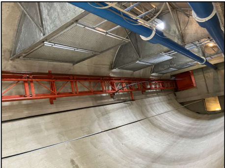
Peinture sur tous les éléments métalliques associés à l'ascenseur (cabine, cage de protection, porte palier, mécanisme, guides, ... // valeur comprise entre 9,48 (v=1,76) et 12,11 (v=1,22) mg / cm²)
