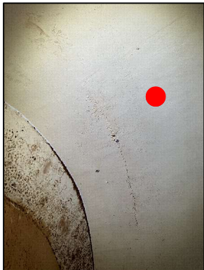
Ind0/P52 - Enduit avec revêtement d'imperméabilisation peinture contenant de l'amiante Chrysotile sur la paroi périphérique (au niveau de la bande horizontale) / A
