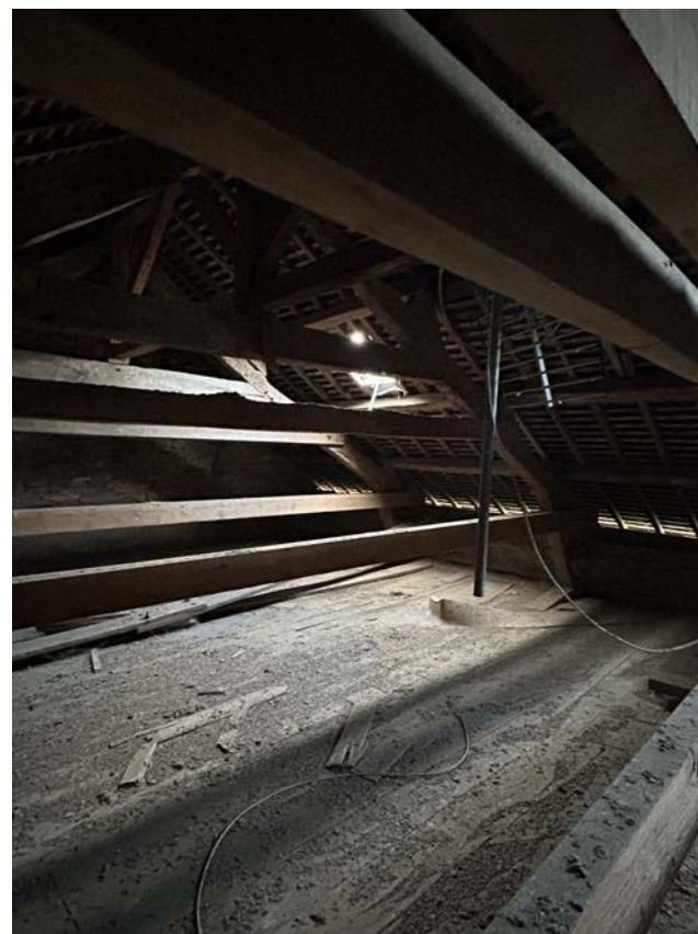
Vue sur les combles de l'Elixir avec les entrails ajoutés sur les fermes
