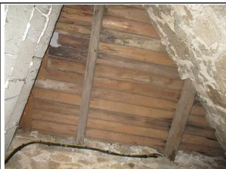
Photo n° PhTer011 Localisation : Rez de chaussée gauche - Chaudière Ouvrage : Charpente Parasite : Anobium punctatum (Petites vrillettes) Indices : altérations dans le bois (infestations faibles) Localisation sur croquis : Point011
