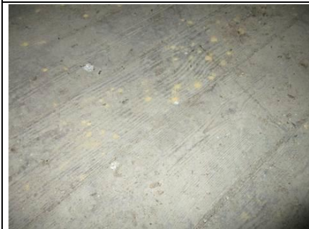
Photo n° PhTer004 Localisation : Combles - Grenier droite Ouvrage : Boiseries. : Plancher bas Parasite : Anobium punctatum (Petites vrillettes) Indices : altérations dans le bois (infestations faibles) Localisation sur croquis : Point004
