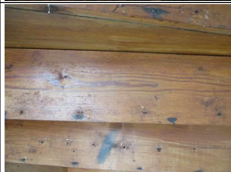
Photo n° PhTer002 Localisation : Rez de chaussée - Cage d'escalier n°1 Ouvrage : Boiseries : Structure bois Parasite : Anobium punctatum (Petites vrillettes) Indices : altérations dans le bois (infestations faibles) Localisation sur croquis : Point002
