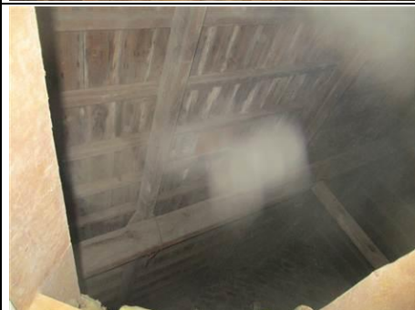
Photo n° PhTer010 Localisation : Combles - Grenier des classes 3 & 4 Ouvrage : Charpente Parasite : Anobium punctatum (Petites vrillettes) Indices : altérations dans le bois (infestations faibles) Localisation sur croquis : Point010
