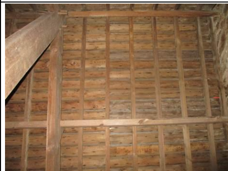
Photo n° PhTer009 Localisation : Combles - Grenier gauche Ouvrage : Charpente Parasite : Anobium punctatum (Petites vrillettes) Indices : altérations dans le bois (infestations faibles) Localisation sur croquis : Point009
