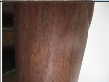
Photo n° PhTer007 Localisation : 2ème étage gauche - Cage d'escalier n°5 Ouvrage : Boiseries : Structure bois Parasite : Anobium punctatum (Petites vrillettes) Indices : altérations dans le bois (infestations faibles) Localisation sur croquis : Point007
