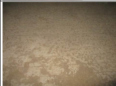
Photo n° PhTer008 Localisation : Combles - Grenier gauche Ouvrage : Boiseries : Plancher bas Parasite : Anobium punctatum (Petites vrillettes) Indices : altérations dans le bois (infestations faibles) Localisation sur croquis : Point008
