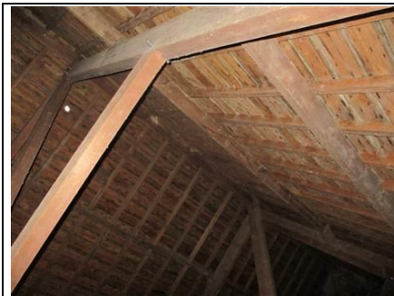
Photo n° PhTer001 Localisation : Combles - Grenier des classes 1 & 2 Ouvrage : Charpente Parasite : Anobium punctatum (Petites vrillettes) Indices : altérations dans le bois (infestations faibles) Localisation sur croquis : Point001
