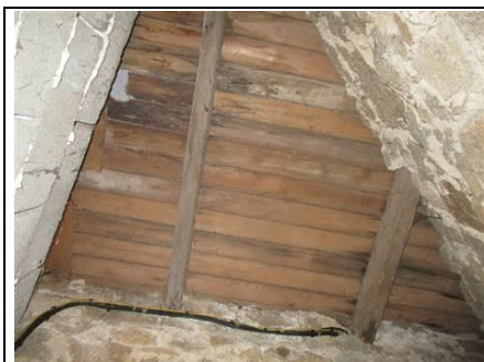
Photo n° PhTer011 Localisation : Rez de chaussée gauche - Chaufferie Ouvrage : Charpente Parasite : Anobium punctatum (Petites vrillettes) Indices : altérations dans le bois (infestations faibles) Localisation sur croquis : Point011
