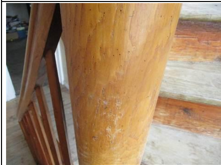
Photo n° PhTer003 Localisation : 1er étage droite - Cage d'escalier n°2 Ouvrage : Boiseries : Structure bois Parasite : Anobium punctatum (Petites vrillettes) Indices : altérations dans le bois (infestations faibles) Localisation sur croquis : Point003
