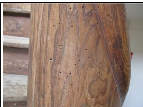
Photo n° PhTer006 Localisation : 1er étage gauche - Cage d'escalier n°4 Ouvrage : Boiseries : Structure bois Parasite : Anobium punctatum (Petites vrillettes) Indices : altérations dans le bois (infestations faibles) Localisation sur croquis : Point006
