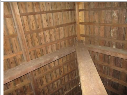
Photo n° PhTer005 Localisation : Combles - Grenier droite Ouvrage : Charpente Parasite : Anobium punctatum (Petites vrillettes) Indices : altérations dans le bois (infestations faibles) Localisation sur croquis : Point005
